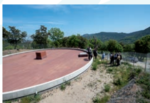
Nouveau réservoir d'eau potable
