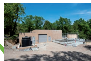
Nouvelle STation d'EPuration
