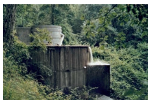
Déviation réseau et démolition de la STEP de l'église en cours
