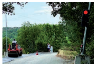
Suppression du feu tricolore
