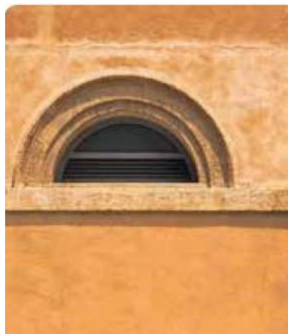
Grilles de ventilation intégrées dans les menuiseries
